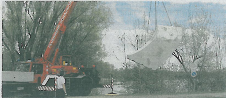
Mithilfe der Donauwörther Feuerwehr wurden die Stegteile am Riedlinger Baggersee ins Wasser gehoben. Foto: Bissinger
