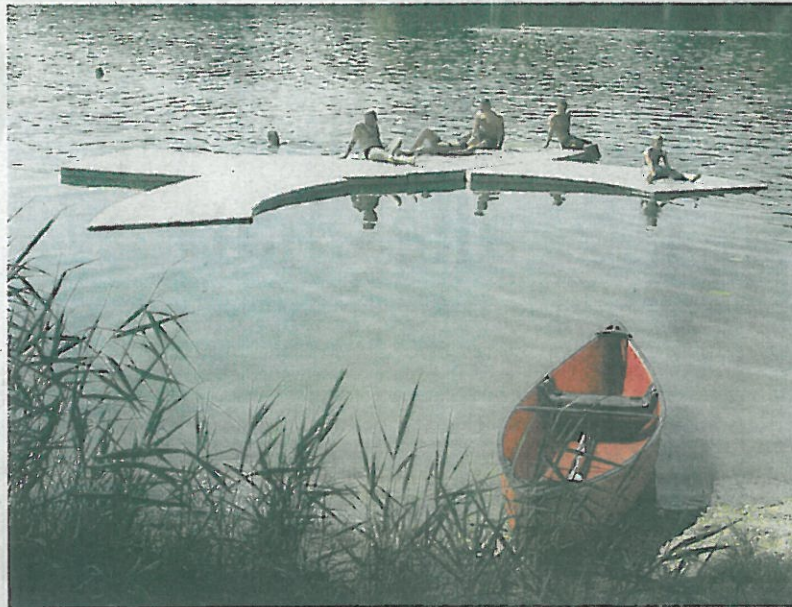
Eine Badeinsel aus Beton schwimmt jetzt nahe der Wasserwachtstation in einem der Badeseen im Riedlinger Naherholungsgebiet.
